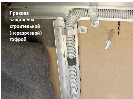
Заготовка провода «главного заземления»
